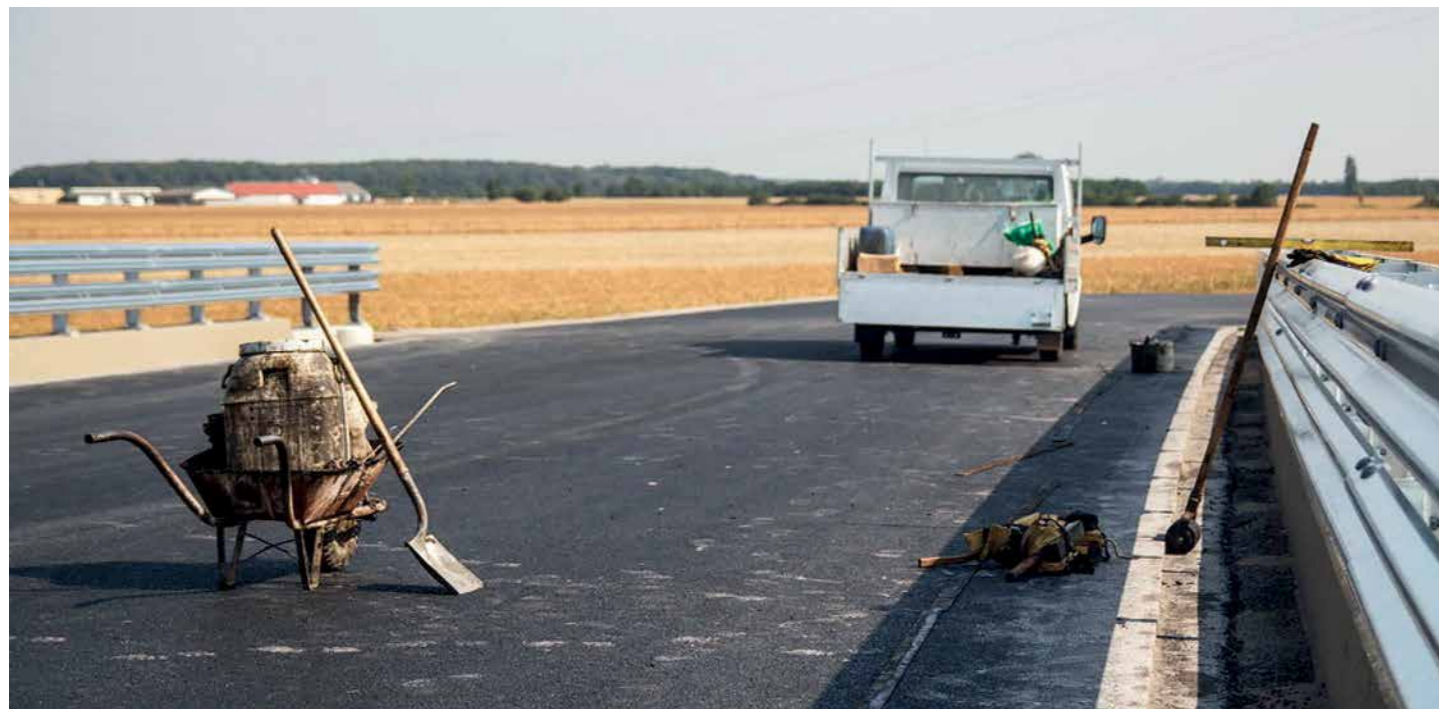
2015-ben elkészült a Nádásd-Hegyhátsál-Katafa közös elkerülő út
